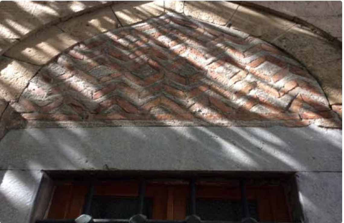
Resim 4. Karagöz Ahmed Paşa Camisi Sivri Kemerli Tuğla İşlemeli Pencere Alınlığı
