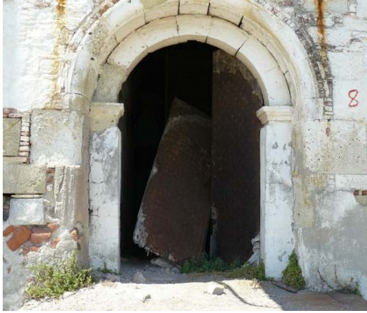
Foto. 3: Ana giriş restorasyon öncesi.
