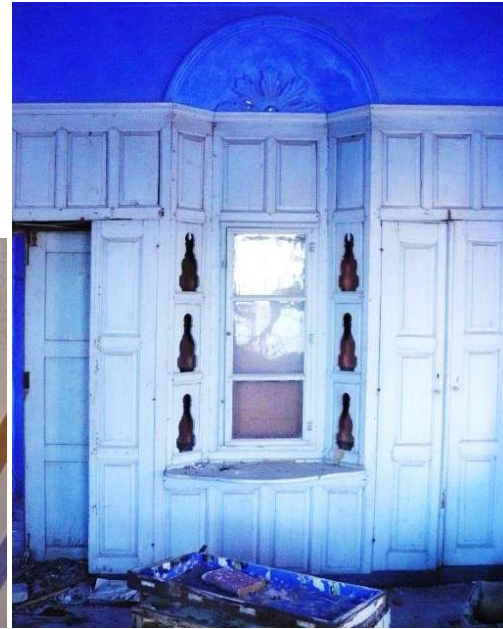
Foto.6: 1.kat kuzeydoğu odası yüklük.
