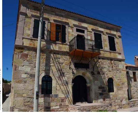
Foto. 9: Restorasyon sonrası, batı cepheden gösterengörünü (Dikili Belediyesi)
