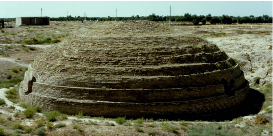
Fig. 11 Kesbe Şehri su haznesi.
