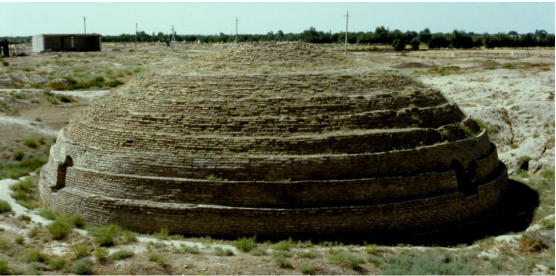
Fig. 11 Kesbe Şehri su haznesi.
