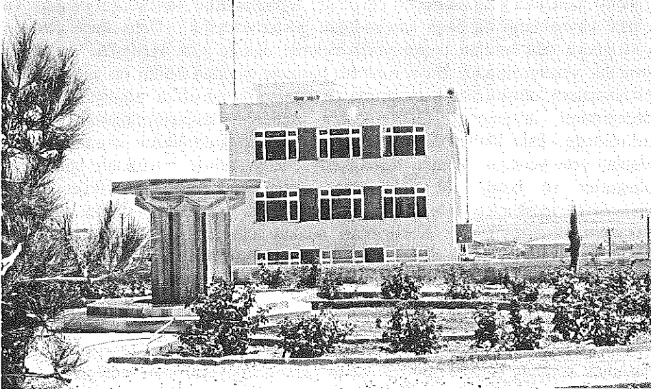
Foto 11: Yeni Halfeti'de belediye binası.
