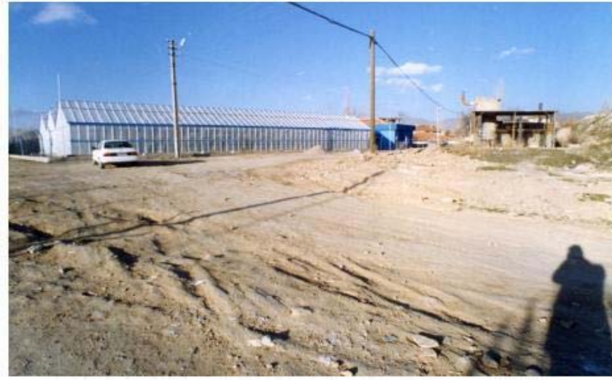
Şekil 11: Jeotermal Santralin Hemen Yakınında Açılan Ancak Su Sıcaklığı Düşük Olduğu İçin Isıtma Amaçlı Kullanılmayan Bir Diğer Kuyunun Suyu, Kırşehir Meslek Yüksek Okulunun Uygulama ve Araştırma Amacıyla Kurulmuş Olduğu Seranın Isıtılmasında Kullanılmaktadır.
