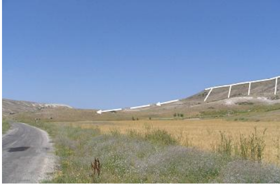
Şekil 10: Karaseki Düzü güney yamaçlarında oluşan ve Akpınar Karaseki arasındaki asfalt yolu etkileyen heyelanlar
