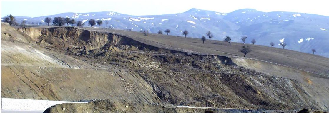
Şekil 6. 3 Numaralı Heyelan Alanı Figure 6. Landslide Area Number 3
