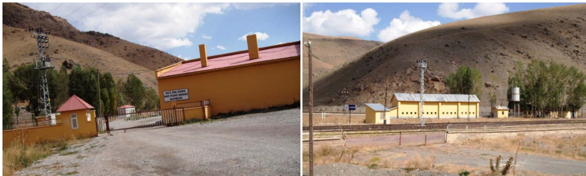
Fotoğraf 1: Araştırma sahasındaki Kapıköy sınır kapısı (solda) ve Kapıköy tren istasyonu (sağda).
