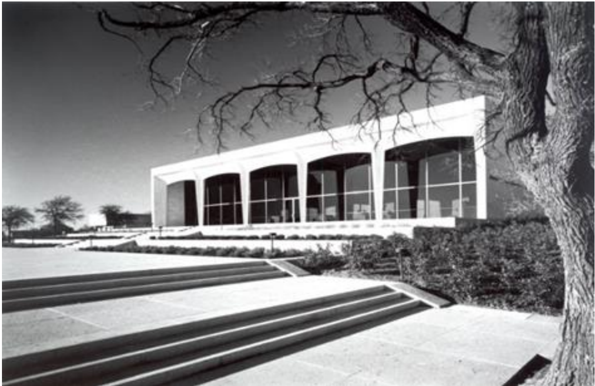
Şekil 7. Philip Johnson, Amon Carter Batı Sanat Müzesi dış cephesi ( Stoller, 1961 ).
