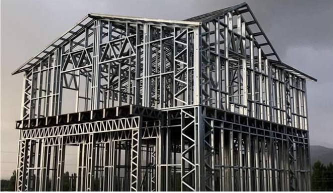
Şekil 3. Çelik prefabrik yapıların taşıyıcı sistemi
