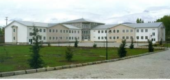
Şekil 7. Türkiye'nin ilk çelik prefabrik okul kampüsü (Türk Yapısal Çelik Derneği Yayını, Çelik Yapılar, 2005)
