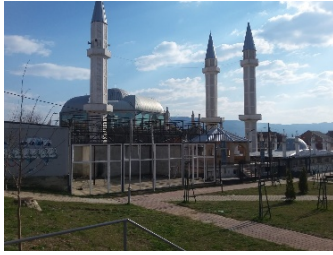
Şutka Amdi Paşin (Paşa) Camii (Dış Görünüş)
