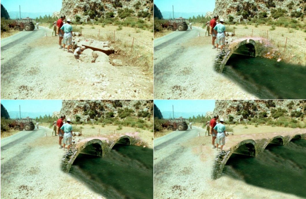
Şekil 32- Patara Kısık boğazındaki antik kemerli kalıntılar. Bir, iki ya da üç gözlü köprü kalıntısı olabilir. Figure 32- Remains of ancient arched structures in the Kısık gorge of Patara. It may be one, two or three-arched bridge remains.
