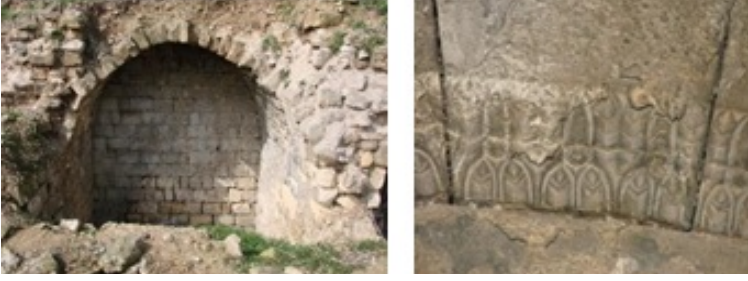
Şekil 5. Duvara İşlenmiş Motif Görünüşleri (Kaynak: Gaziantep Büyükşehir Belediyesi Restorasyon Kurulu Arşivi, Erişim Tarihi: 2019)
