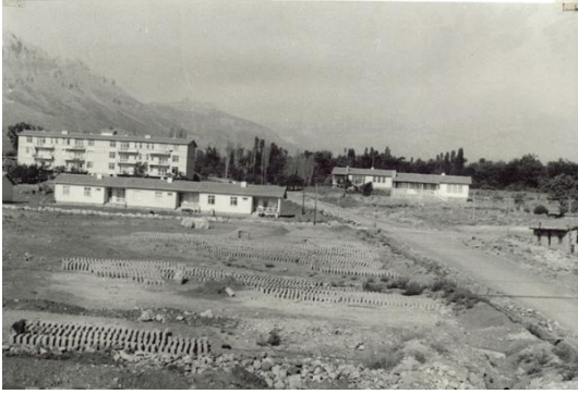
Şekil 5. 1971 Yılına Ait Seydişehir Alüminyum Tesisleri Yerleşkesi Lojman İnşaatı [22].
