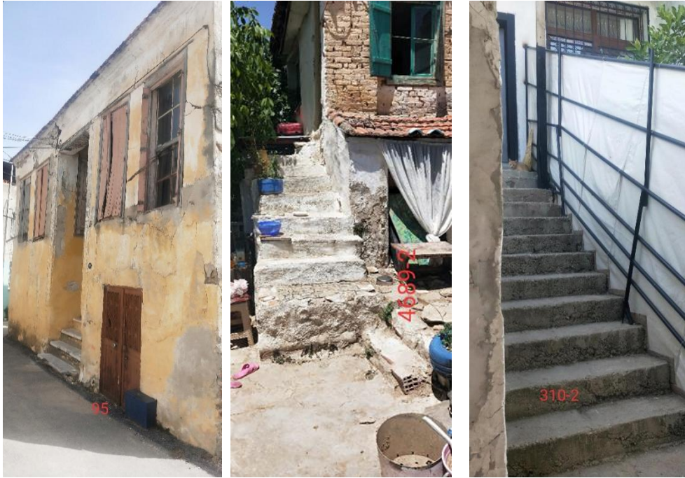
Şekil 7. Avlu ya da bina girişlerinde yaşlıların ya da çocukların ya da engellilerin girmesini güçleştirecek merdiven ya da kot farkı örnekleri (Yazar arşivi).
