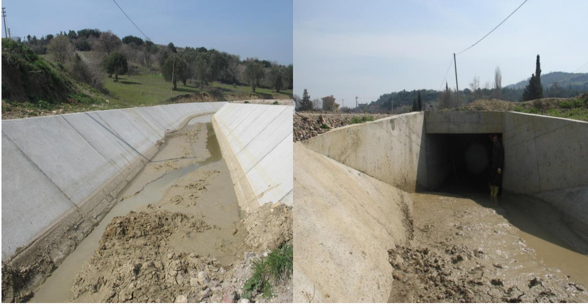
Şekil 4. Kış mevsiminde (Şubat 2010) aşırı yağışlardan sonra bir sulama kanalındaki toprak kaybı.
