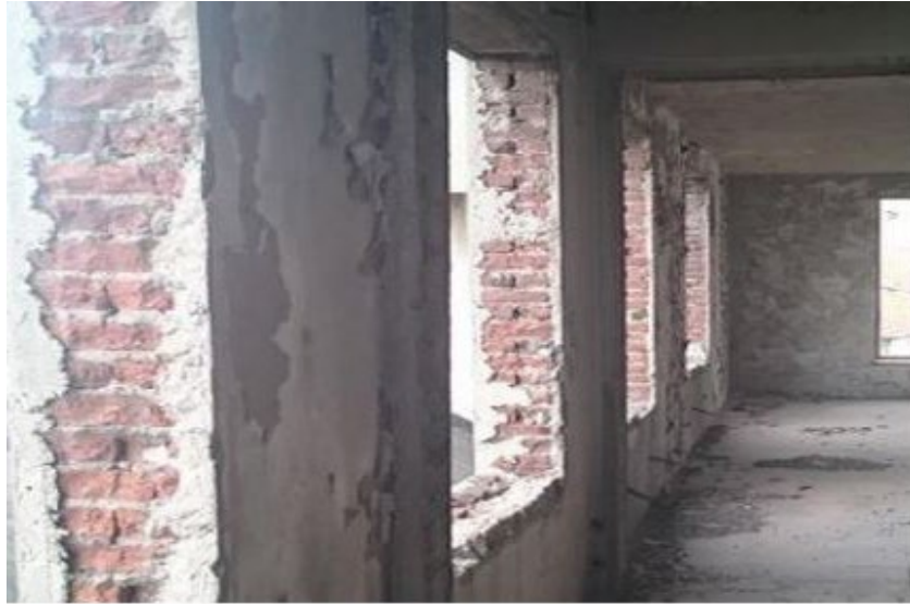
Şekil 20. Tolon Fabrikası Dış Duvar Yığma Tuğla Örgüsü (Kaynak: Ayengin Ş., Şen E.)
