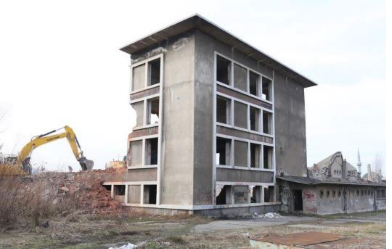
Şekil 14. Tolon Fabrikası Yıkımı (Kaynak: Url-5)
