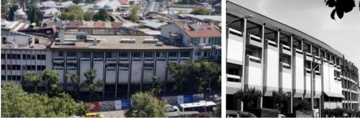
Şekil 15. Solda, Merkez Bankası yıkım öncesi (Faruk Özgökçe)
