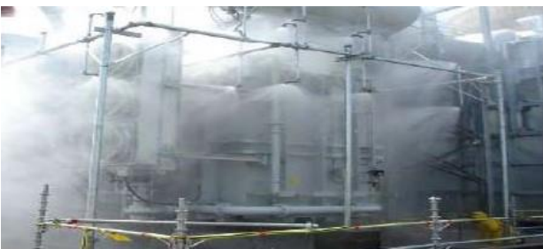
Şekil 5. Açık Uçlu Sprinkler Sistem [14]
