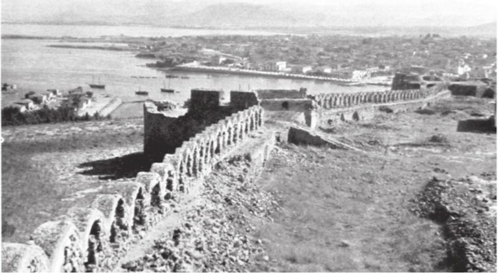
Ek 5 Karababa Kalesi'nden Ağrıboz Boğazı (Kale Duvarı ve Burçları) 33
