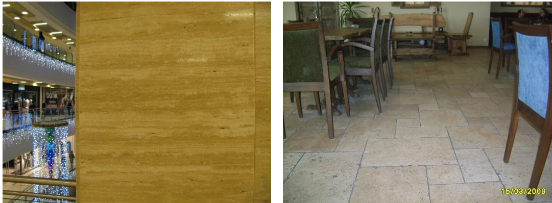
a- Vein-cut kesilmiş traverten uygulaması
