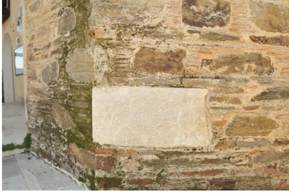
5. Posacızade Hacı Hasan ve Hacı Hüseyin Camii Minare Kaidesi (O. Ülkü)
