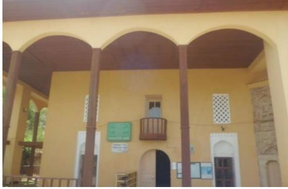
7. Posacızade Hacı Hasan ve Hacı Hüseyin Camii Giriş Cephesi (O. Ülkü)
