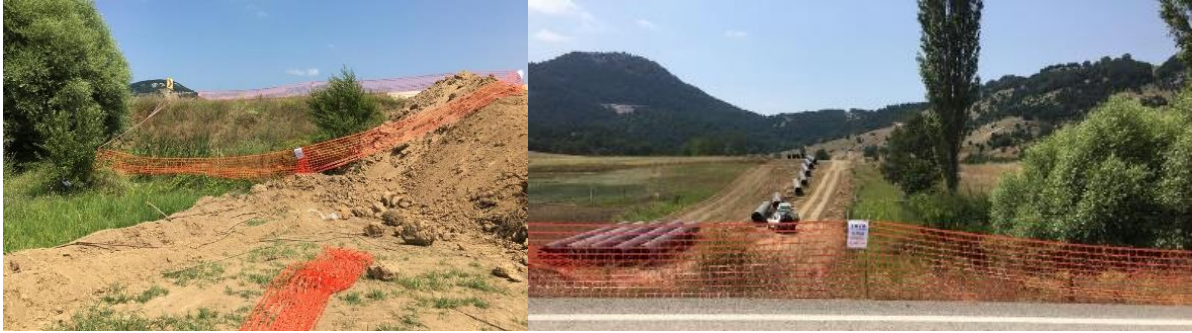
Şekil 2. Endemik tür popülasyonu üzerinden geçen doğalgaz boru hattı çalışması.
