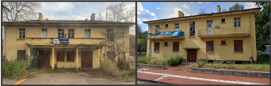
Görsel 6. Işıkeren tren istasyonu istasyon binası ön ve arka cephesi (2021)
