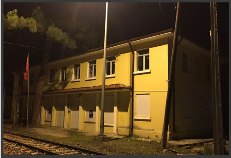
Görsel 10. Cildikısık tren istasyonu istasyon binası (2021)
