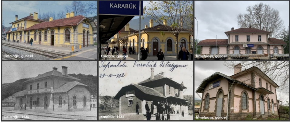
Görsel 4. III. Sınıf proje ile inşa edilen Çatalağzı, Karabük ve İsmetpaşa istasyonları (Çatalağzı istasyonunun 1936 tarihli fotoğrafı: URL 11, 2023; Karabük istasyonunun 1932 tarihli fotoğrafı: URL 12, 2023; güncel fotoğraflar: yazar, 2022.)
