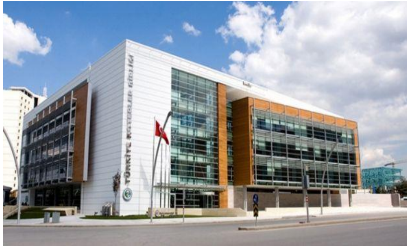
Şekil 4.4. Türkiye Noterler Birliği, montaj işlemi tamamlandıktan sonra cephe görünüşü
