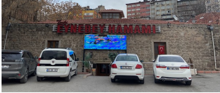
Şekil 27. Eynebey Hamamı dış cephe (Kaynak: Yazarlara ait fotoğraf arşivi)
