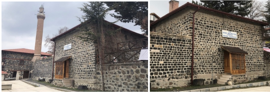
Şekil 41. Ayaş Paşa Hamamı dış cephe (Kaynak: Yazarlara ait fotoğraf arşivi)
