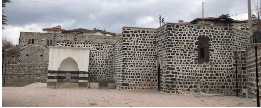
Şekil 46. Karakaya Hamamı dış cephe
