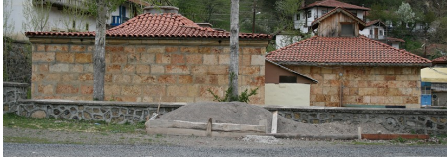
Şekil 34. Kızılcahamam Sey Hamamı dış görünüşü (Kaynak: Yazarlara ait fotoğraf arşivi)
