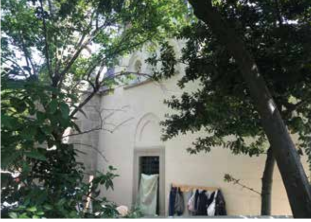
Fotoğraf 14. Caminin güneybatı cephesi (Fotoğraf yazar tarafından çekilmiştir, 2022). / Southwest facade of the mosque (Photo taken by the author, 2022).
