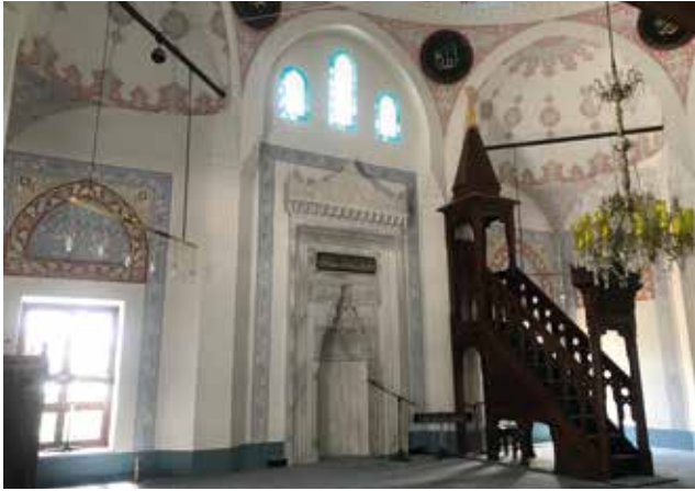
Fotoğraf 9. Harimden caminin güneydoğu duvarı, ayaklar, kemerler, pandantifler ve köşe trompu (Fotoğraf, yazar tarafından çekilmiştir, 2022). / Southeast wall of the mosque from the harim, pillars, arches, pendentives and corner squinch (Photo taken by the author, 2022).
