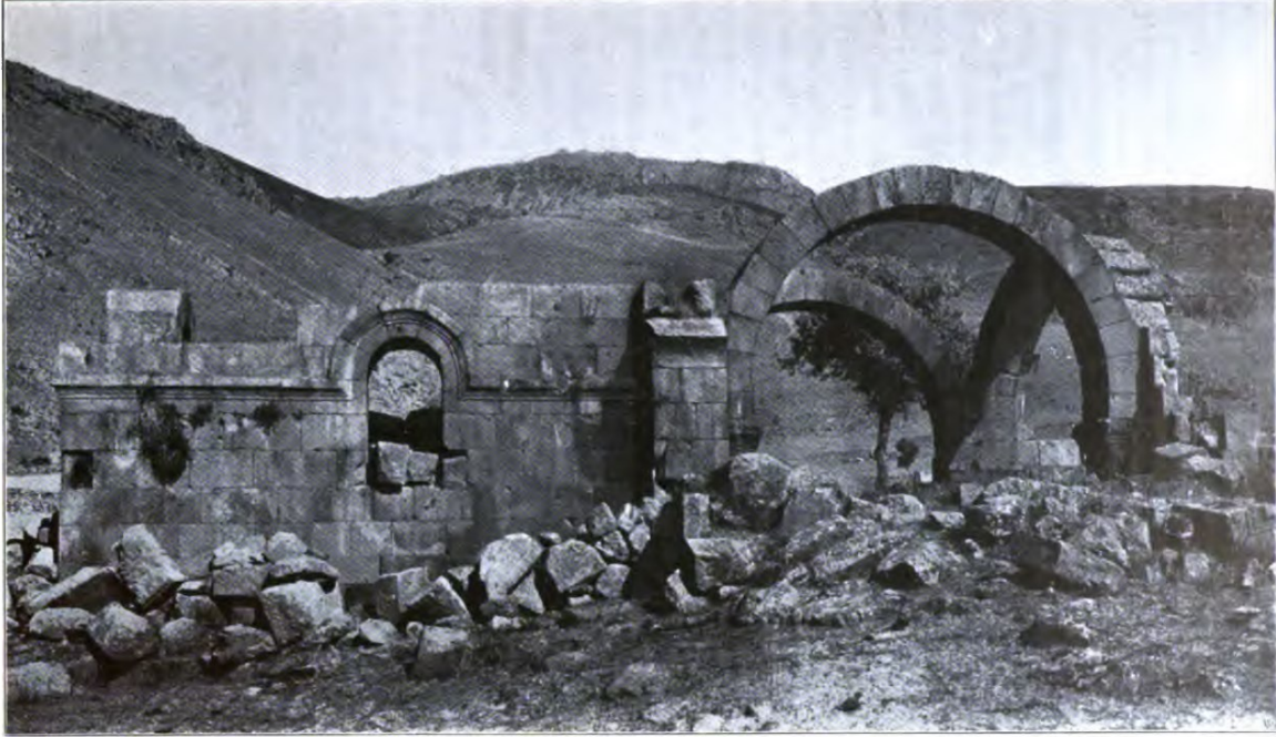
Şekil 4. Çanlı Kilise (Rott, 1908)
