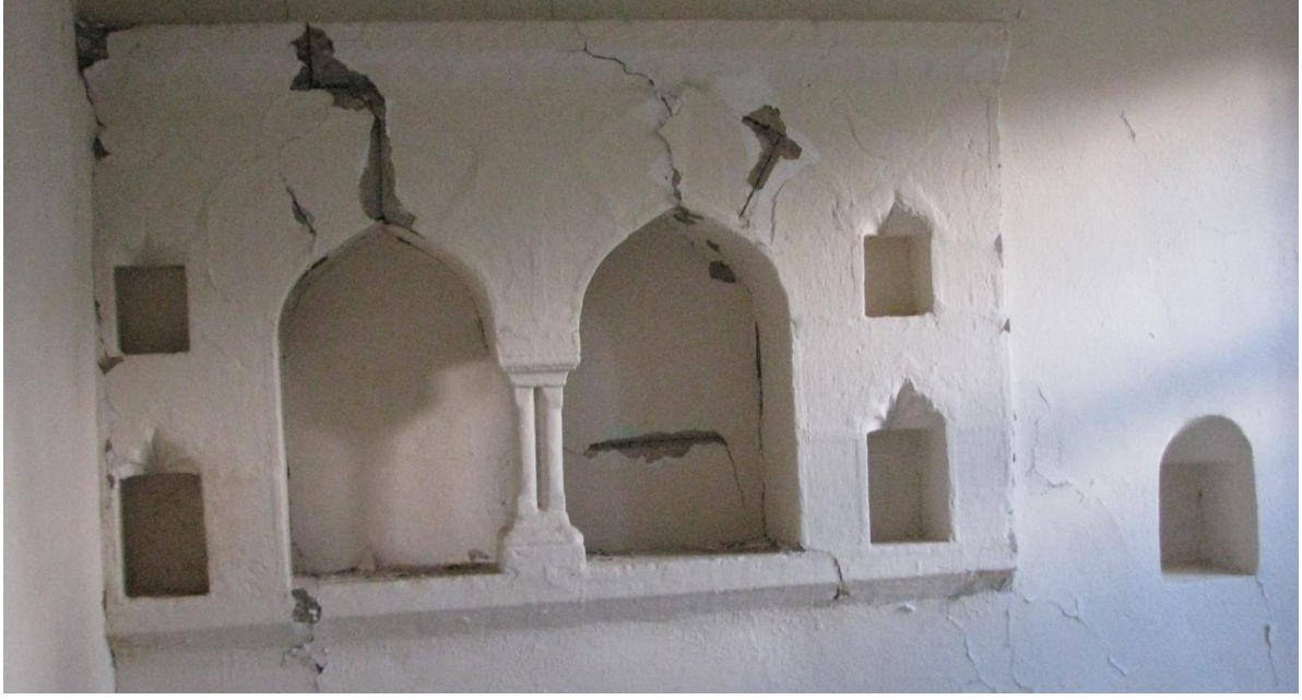
Res. 12: Fikri Kızılkaya Evi Üst Kat İç Mekân Niş Hasar Görünüşü (Ş. Öztürk)
