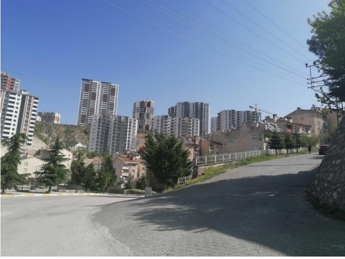
Şekil 10. Tokat kenti kuzey bölümündeki kentsel dönüşüm kapsamında yapılan konutlar ve henüz dönüşüm kapsamına alınmayan konutlar (Bu görsel yazar tarafından oluşturulmuştur).
