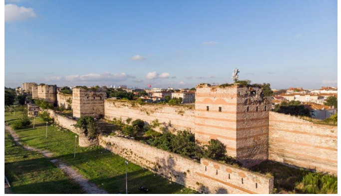
Şekil 1: Kara Surları Genel Görünüm 23
