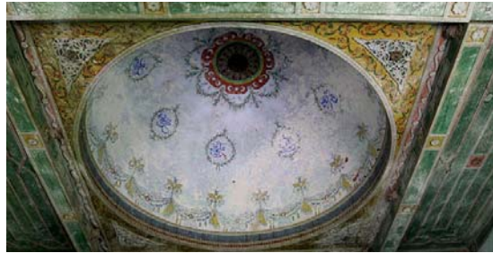
Fotođraf 38: Persa Cami, bađdadi kubbe ve süsleme ayrıntıları (Şen, 2017).
