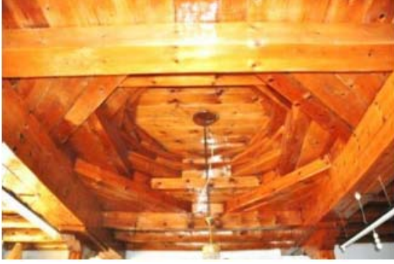
Fotoğraf 51: Bayburt Demirözü Güvercindere Köyü Cami, kırlangıç tavan (Özkan, 2012)
