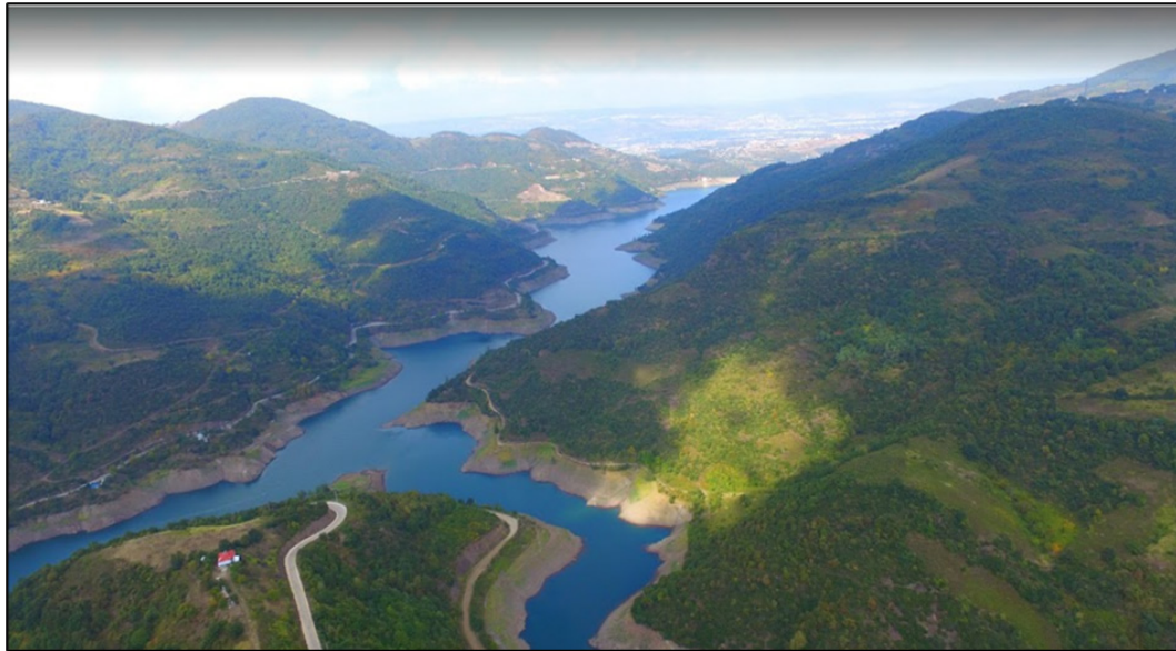
Foto 1- Yuvacık Barajı'ndan genel görünüm (maps.google.com) Photo 1-General view from Yuvacık Dam
