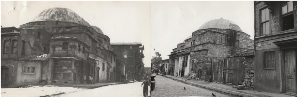
Resim 3. İtfaiye Caddesi yönünden Zeyrek Çinili Hamam'ın görünüşleri, İstanbul Eski Eserleri Koruma Encümeni Arşivi
