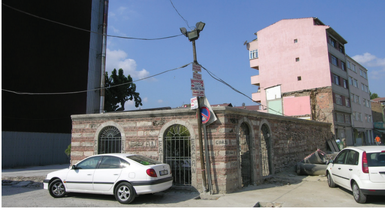
G. 10: Tekkenin türbe duvarları ve hacet pencereleri (Müfid Yüksel, 2006)
