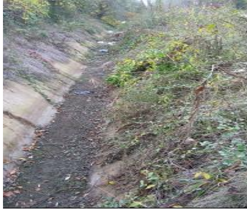
Şekil 2-7 Otoyol kenarındaki yağmur suyu kanallarından bir görünüm
