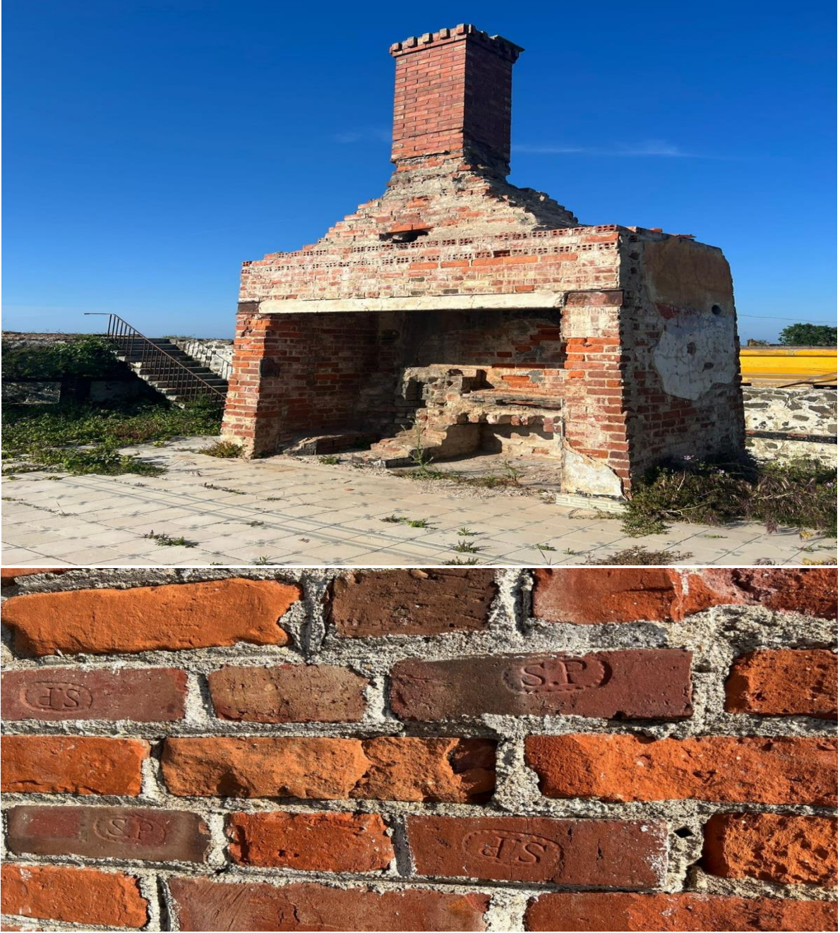
Ek.1. Beykoz Riva Tahliye İstasyonu Koğuşuna Ait Pierre Salomon (Büyükdere) Tuğla Fabrikası'nda Üretilen Tuğla Örnekleri
