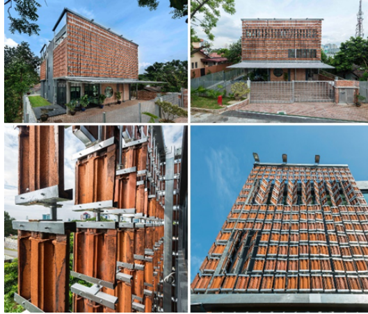
Şekil 11. Brise-soleil tekniğine göre cephe yerleştirme
