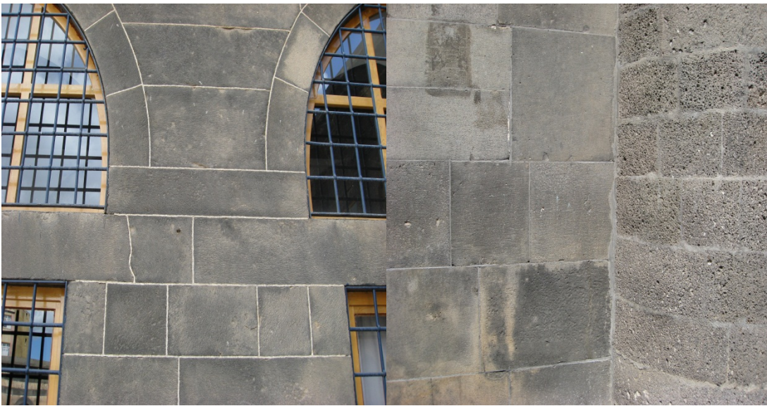
Fotoğraf 4: Kilise giriş kapısı söve taşları ve tuğla ile karışık dış cephe moloz taş duvar
