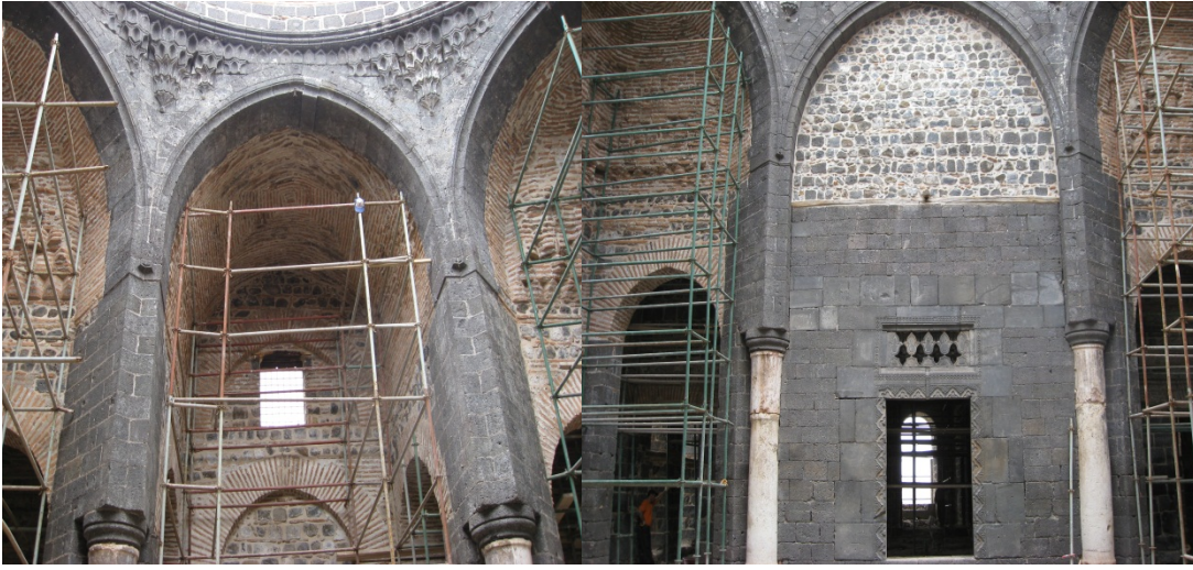
Fotoğraf 3: Kilisede Kubbenin oturduğu kemer, tonozlar ve giriş kapısı.
