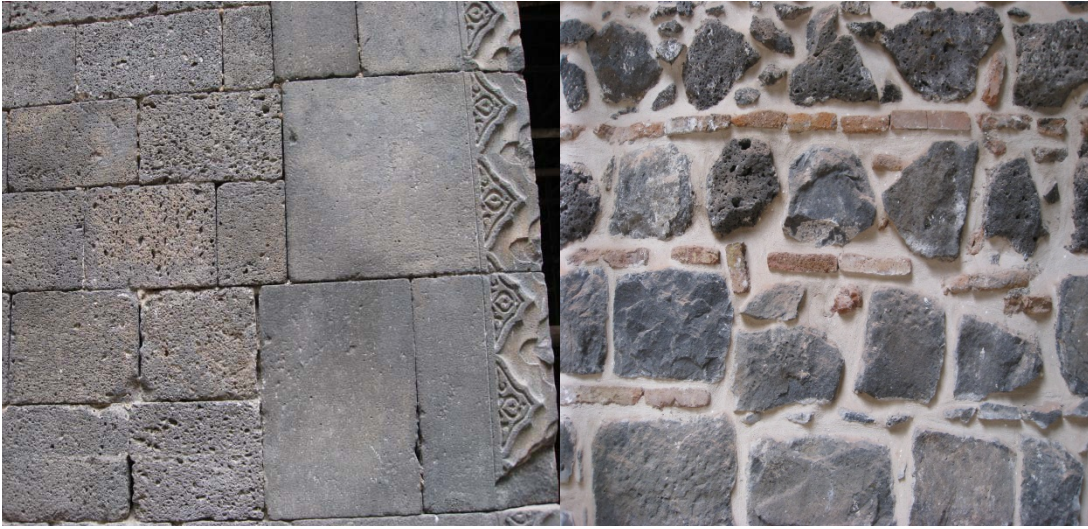
Fotoğraf 4: Kilise giriş kapısı söve taşları ve tuğla ile karışık dış cephe moloz taş duvar
