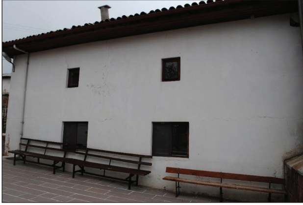
Fotoğraf 11: Kızılcaören Köyü Camii doğu cephe.
