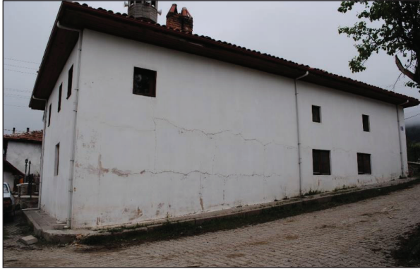
Fotoğraf 9: Kızılcaören Köyü Camii batı cephe.
