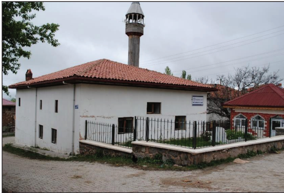
Fotoğraf 7: Kızılcaören Köyü Camii güney ve batı cepheler.
