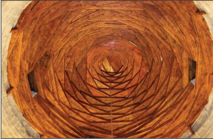
Fotoğraf 1: Erzurum Ulu Camii kırlangıç kubbe.
