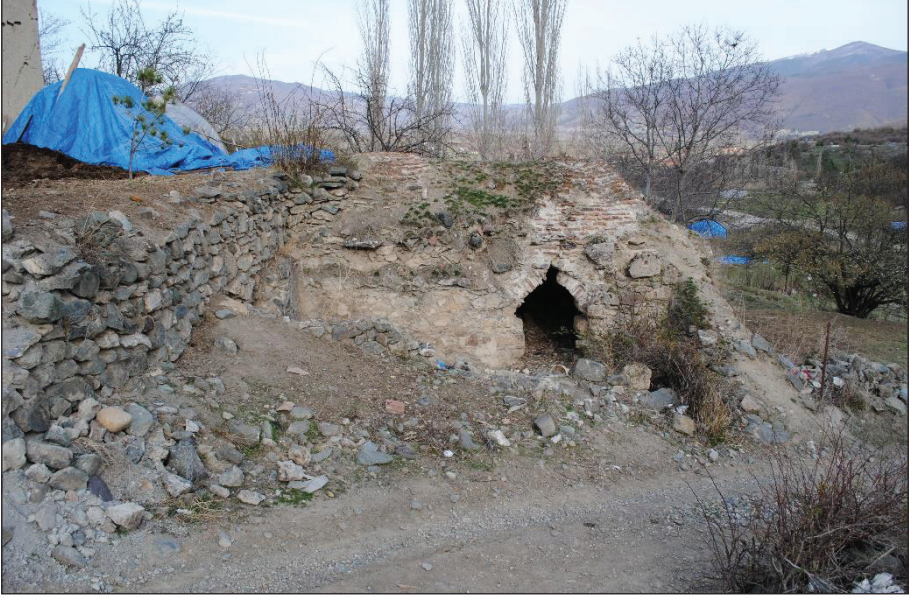
Fotoğraf 10: Hamam Batı Cephe (Sıcaklık Girişi)
