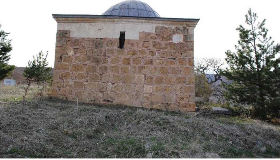
Fotoğraf 3: Türbe Batı Cephe
