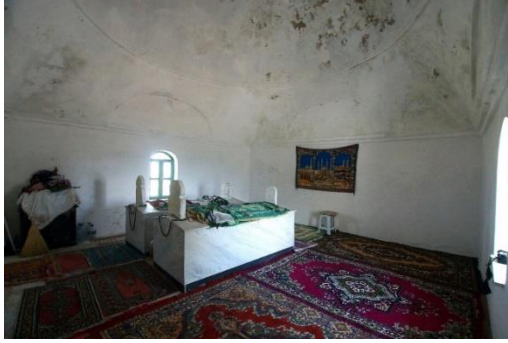
Foto. 22: İç Mekân Doğu ve Kuzey Duvar Duvar
