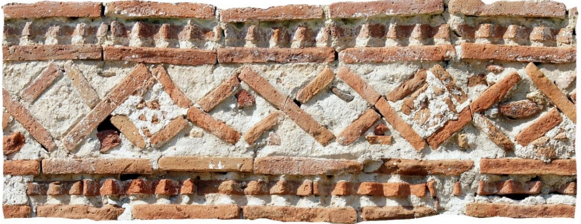
Foto. 10: Güney Cephe Tuğla Süsleme
