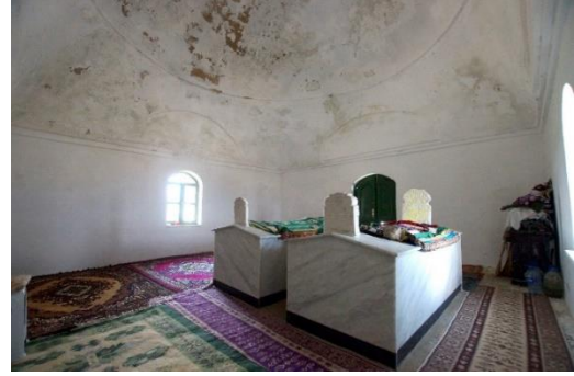
Foto.23: Türbesi İç Mekân, Batı ve Güney Duvar
