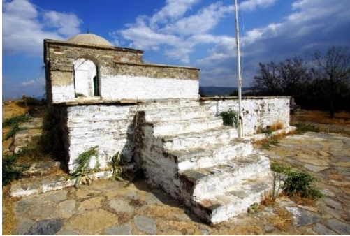
Foto. 13: Kuzeybatı Görünüm ve Teras
