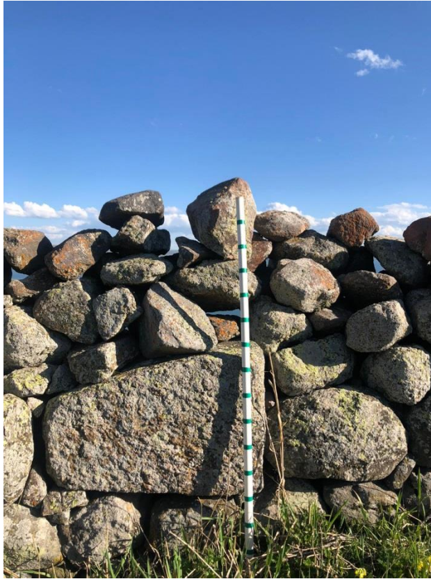
Foto 7. Sengertepe Kalesi Sur Duvarları
