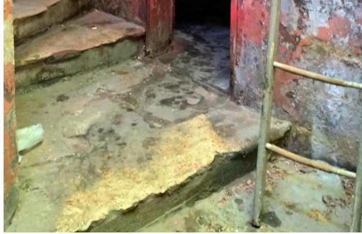
Şekil 1. İnsan Hareketleri Sonucu Aşınan Merdivenler
