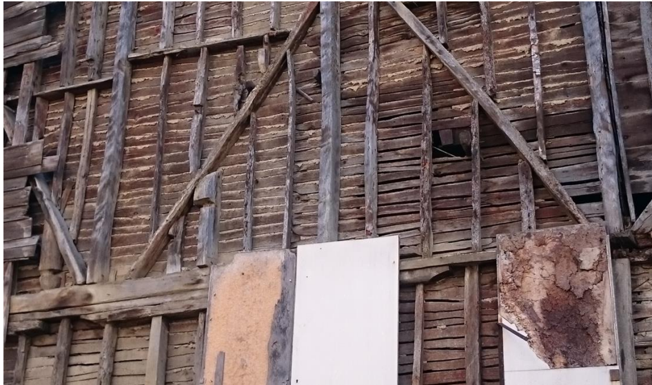
Şekil 3. Ahşap Cephede Biyolojik Faaliyet Sonucu Çürümeler
