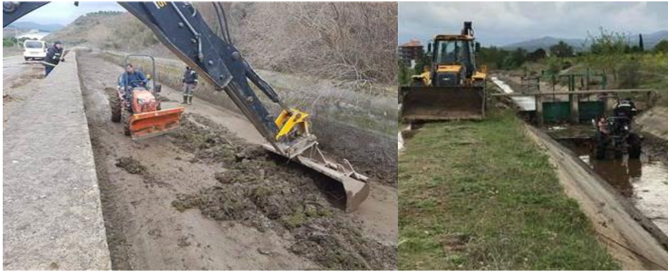
Şekil 2. Bayramiç-Ezine Ovaları Sulama Birliği ana kanalı temizliğinden iki görünüm
