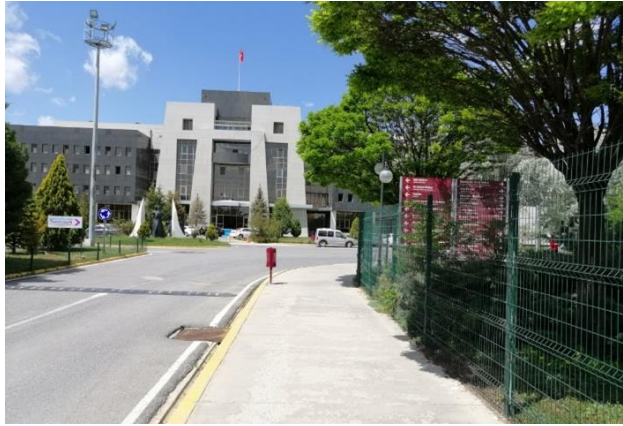
Şekil 3. Afyon Kocatepe Üniversitesi Yerleşkesi'nde yönlendirme tabelası uygulamadan önceki şekli
