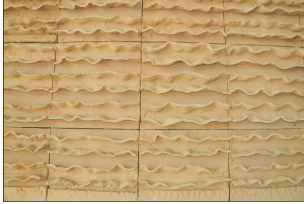
Fotoğraf 8. Batı duvarı devinim panosunun alt bölümü
