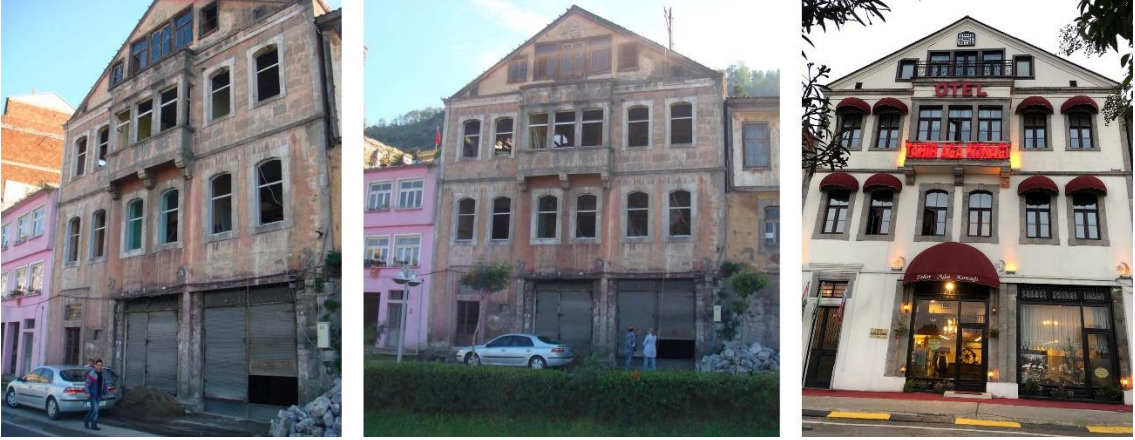
Görsel 2. Tahir Ağa Konağı restorasyon öncesi (Akçay, 2007) ve sonrası kuzey cephesi (Yalçın, 2019).
