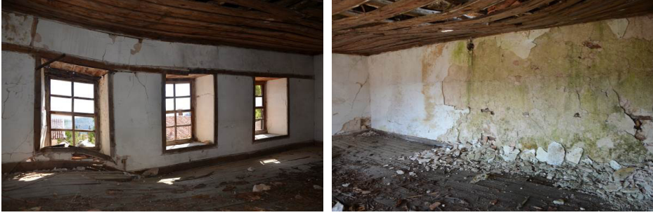
Fot. 46-47: Güzelsu Köyü Mecidiye Medresesi Batıdaki Mekânın İçten Görünüşü
