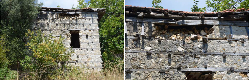
Fot. 5-6: Güçlüköy Camisi Güney Cephe
