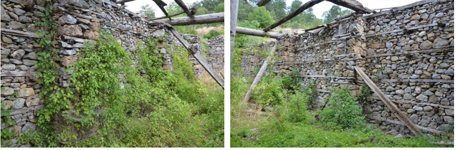
Fot. 28-29: Bademli Köyü Hani, İçten Kuzey ve Güney Duvarlardaki Payandalar
