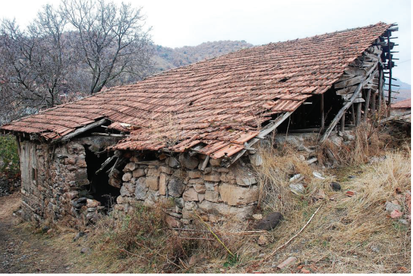
Fotoğraf 18: Meşeli'de yer alan yapının örtü sistemi (kuzey doğu yönünden)
