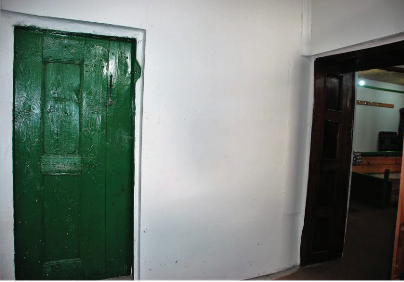
Fotoğraf 3: Kargın'da yer alan yapının "papaşluk" bölümünden ana mekân ve mutfak giriş kapılarının görünümü
