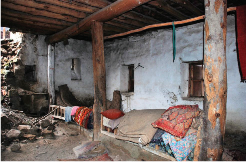
Fotoğraf 13: Meşeli’de yer alan yapının pencereleri (içten)
