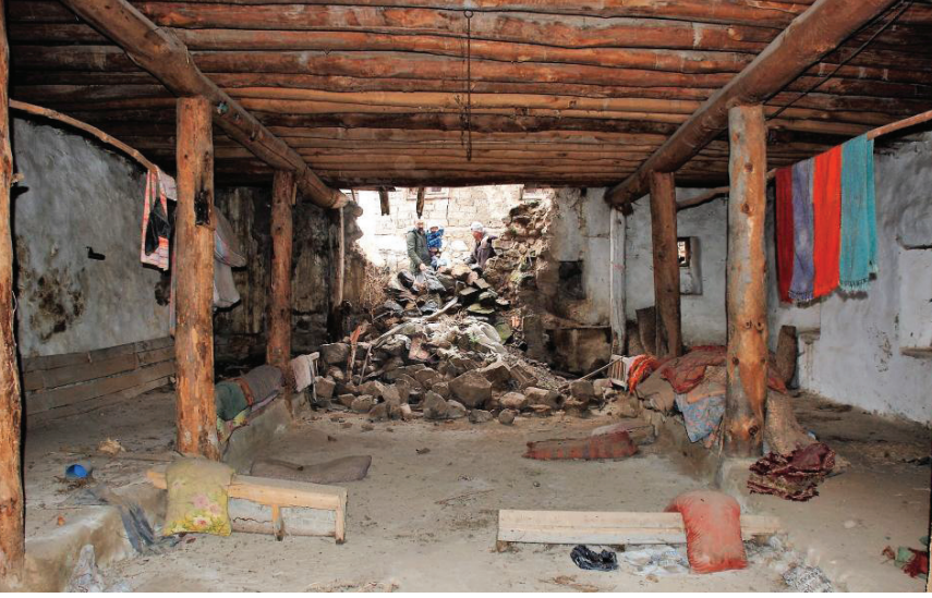
Fotoğraf 12: Meşeli’de yer alan yapının iç mekânı
