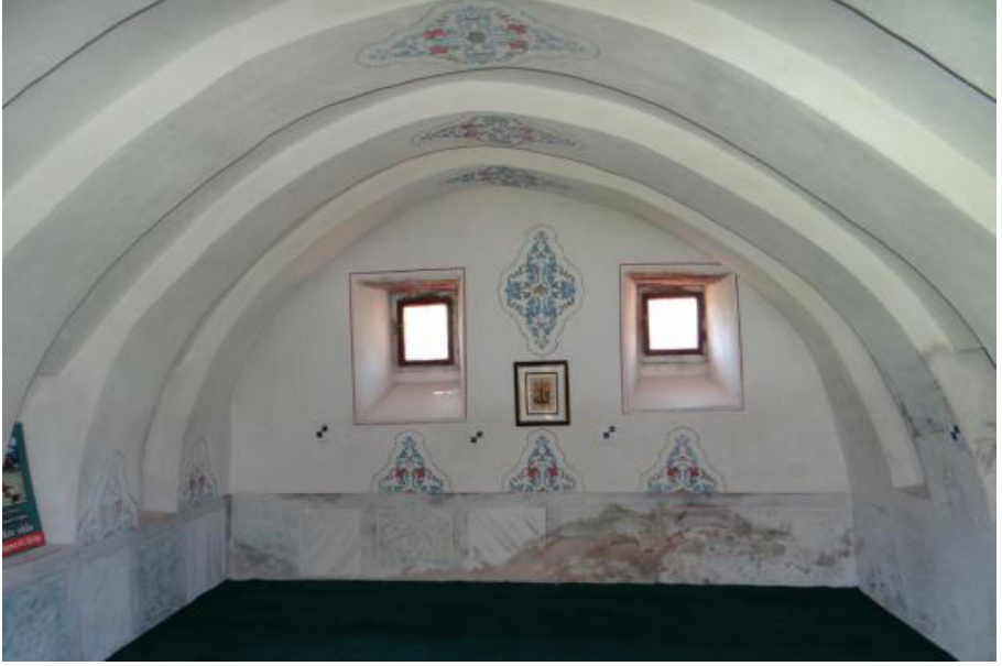
Fotoğraf 13. Cem Odası güney duvarı.
