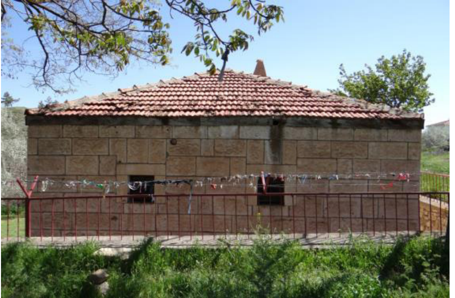
Fotoğraf 6. Batı cephe.
